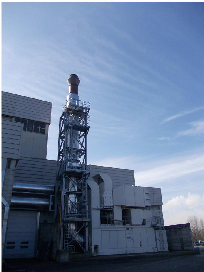
*Figura 27 - Impianto di cogenerazione da 4 MW nello stabilimento Padana*
