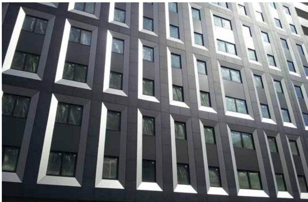
modularità delle finestre dei locali e dei bagni alternate in due sole dimensioni, permette di annullare la scala delle aperture reali, tra loro unite a livello visivo tramite un pannello di alluminio brunito, come in un riuscito effetto di trompe l'oeil.
